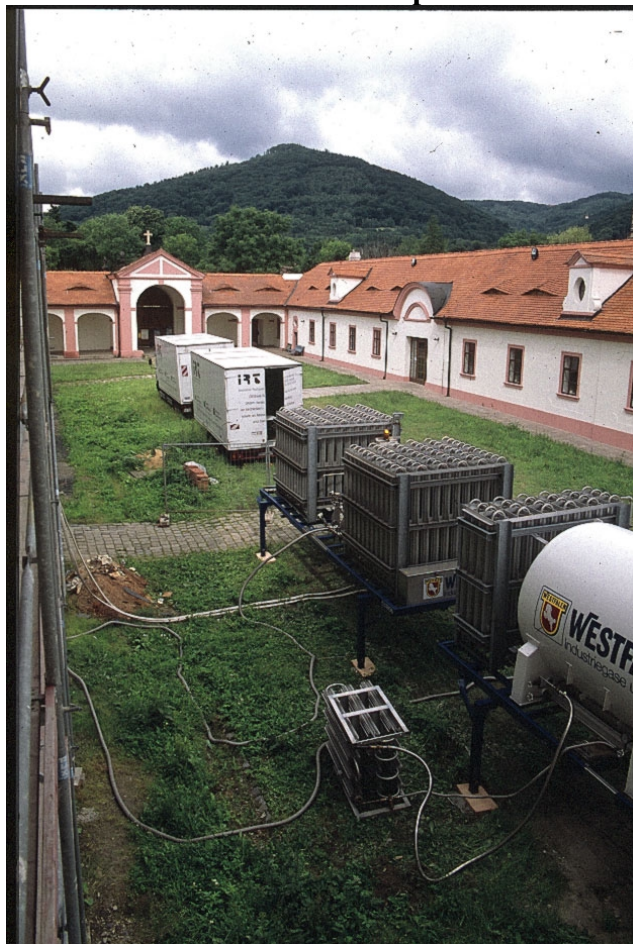
Abb. 5: Gastank und Verdampfereinheiten
